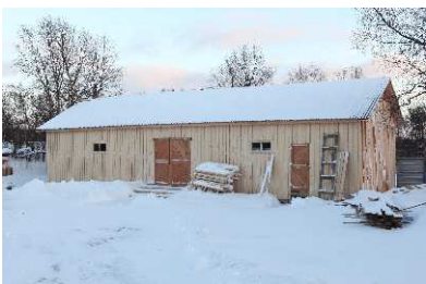
Своими силами построено новое складское помещение
