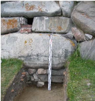
Основание стены Соловецкой крепости конца XVI века к югу от Архангельских ворот. Нижние мелкие камни уложены поверх материка. Фундамент отсутствует.
