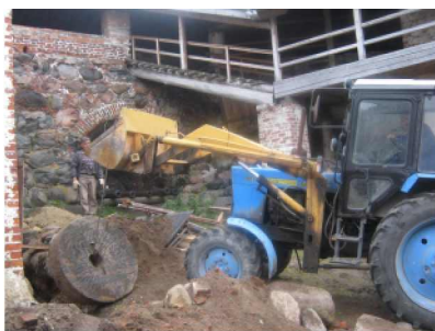
Подъём жёрнова из траншеи у южной стены пристройки к Прачечному корпусу
