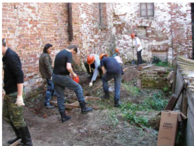
Разбор строительного мусора перед западной стеной Настоятельского корпуса. Работают студенты Православного Свято- Тихоновского университета.
