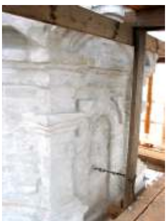
Завершение реставрации барабана
