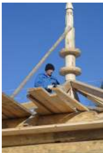
Строительство часовни на поселковом кладбище
