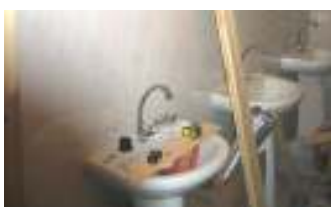
Монтаж санитарно-технического оборудования
