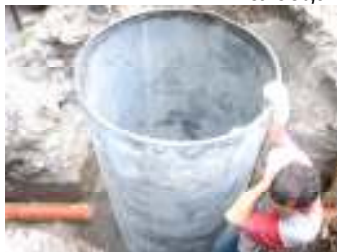
Монтаж канализационного колодца
