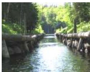
Озерно-канальная система Соловков – уникальный памятник гидротехнического строительства
