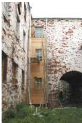
Реставрация фасадов Новобратского корпуса
